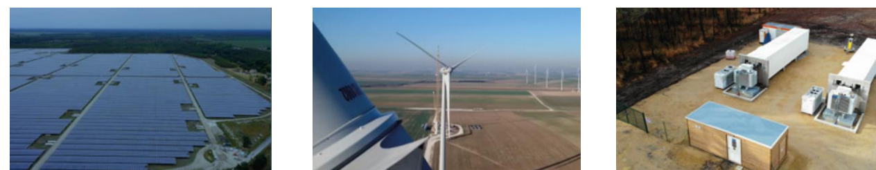
Figure 2 : de gauche à droite, Centrale Solaire de Cestas (300 MWc), Centrale Eolienne de Bussy-Lettrée (26 MW), et Azur Stockage (6 MW, 6MWh) (source : NEOEN, 2019)
